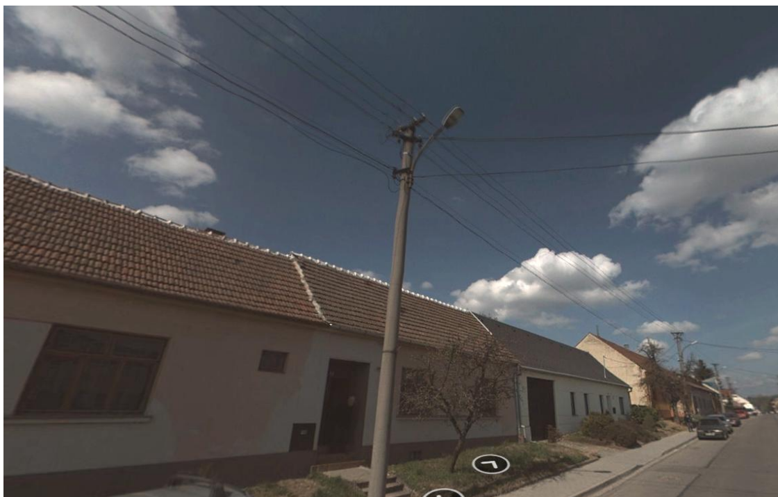
Obrázek č. 14: Veřejné osvětlení a elektrické vedení v obci; zdroj: Mapy.cz .
