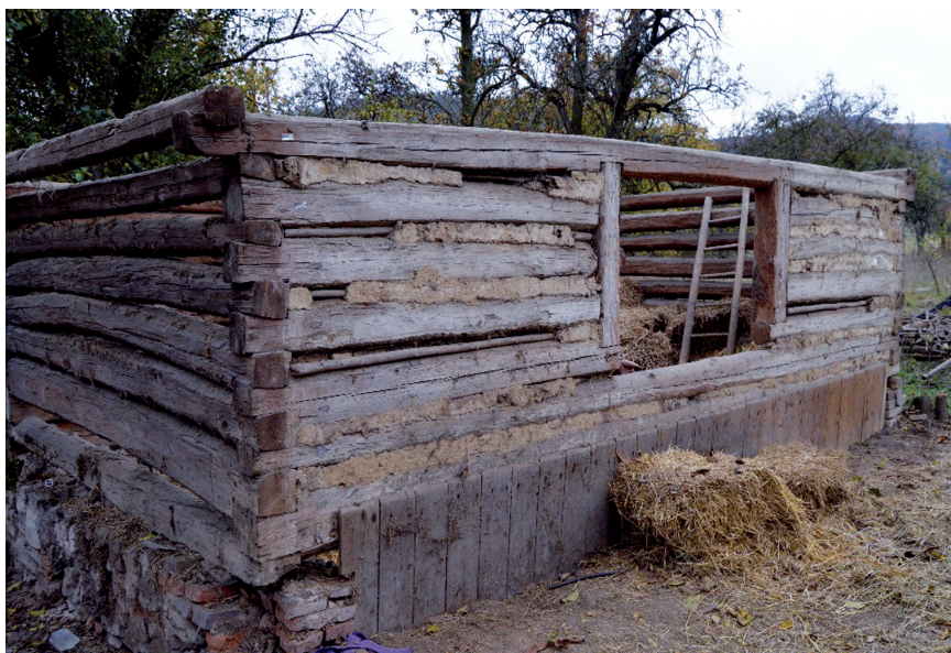
Stavba očesána na původní roubenou konstrukci. Stěna ze strany mlatu se zbytky původní hliněné vymazávky
